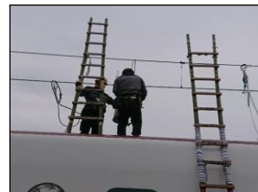
〔車両上での電車線復旧訓練〕
