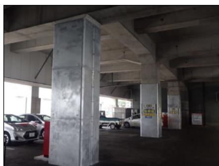
〔鋼板巻立補強工法(行橋駅)〕
