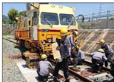
〔保守用車脱線復旧競技会〕
