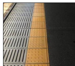
[内方線付き点状ブロック]
