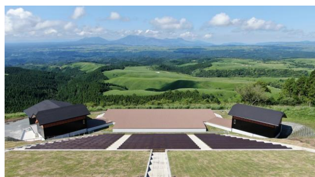
天空の展望公園 (建設中)
